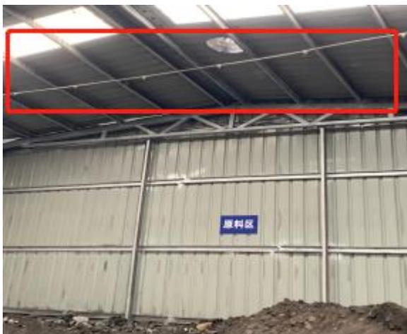
出料口水雾喷淋抑尘装置：
