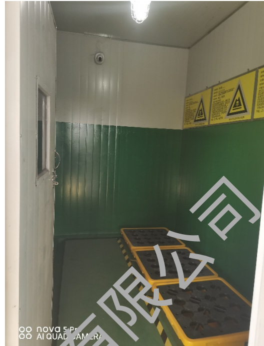
危废仓库内部
