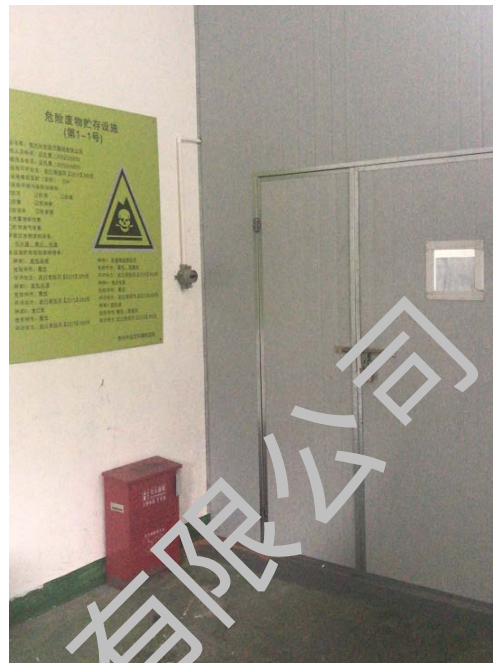
危废仓库外部及标志牌:
