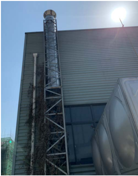
FQ-02 排气筒（天然气燃烧废气）
