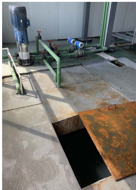
淋雨试验废水收集池：
